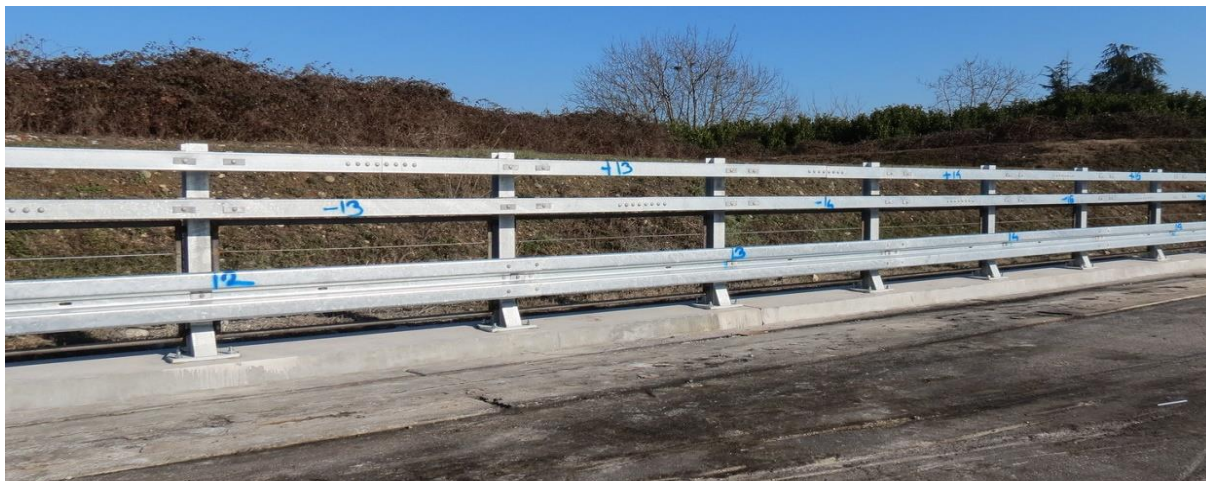
Obrázek 2a: Pohled na zábradelní svodidlo STP-10M/2
